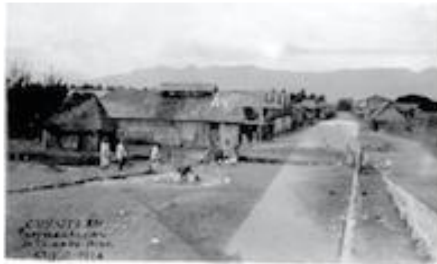
Imagen 7. Pavimentación de la calle principal de Cuyutlán, 1926.
